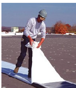
Монтаж ПВХ мембраны
